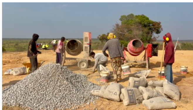
Klaar om ruim 60 kuub beton te mixen
