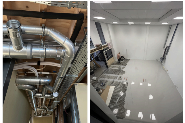
Installatiewerk en simbay gietvloer
