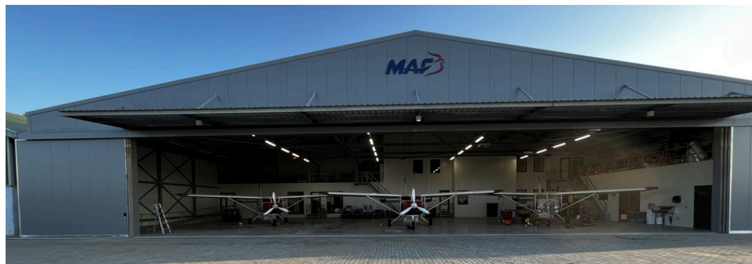
De in 2023 nieuw gebouwde hangaar van MAF Suriname
