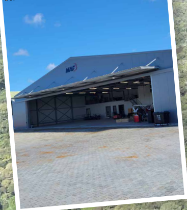
Nieuwe hangaar in bedrijf
