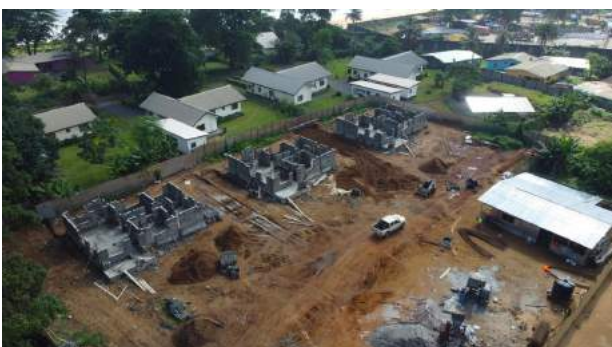
De bouw is in volle gang. Erachter staan de huidige MAF huizen.
