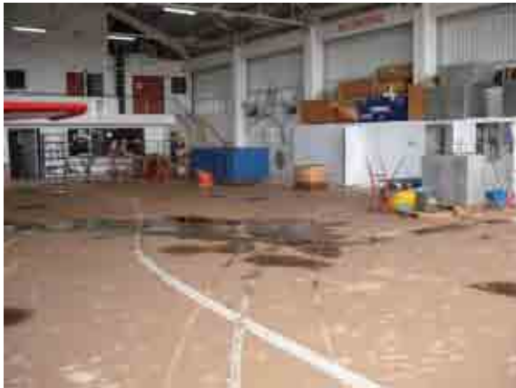
Laag modder op de hangarvloer makkelijk te verwijderen dankzij nieuwe verf
